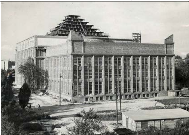
↑ Budowa Gmachu Głównego przy al. Niepodległości, 1954 r.
