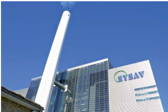
Ekologiczna spalarnia odpadów Sysav w Malmö
